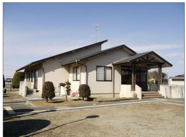
つどいの広場みなみかわら
