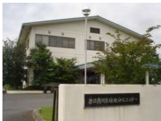
【妻沼南河原環境浄化センター】
