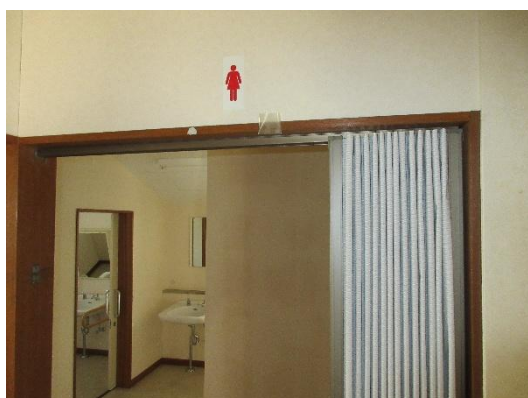
旧障害者福祉センター（女子便所）
