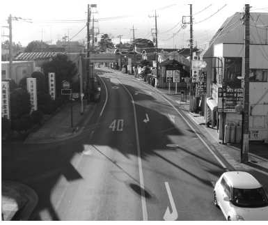
市役所北側国道125号線
