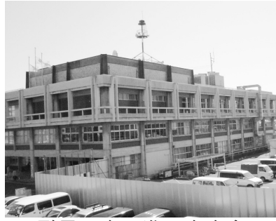
耐震工事の進む本庁舎
