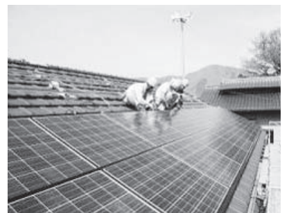
ソーラーパネルの設置
