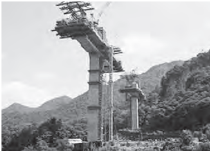
八ツ場ダム（第2橋脚）
