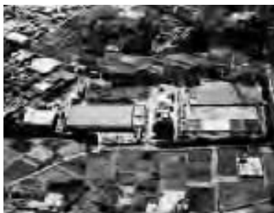
元荒川水循環センター（桶川市）
