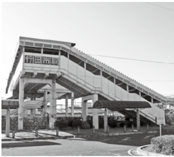
秩父鉄道行田市駅跨線橋
