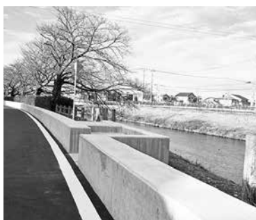
強化された忍川堤防（緑町地内）
