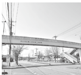
泉小学校前歩道橋
