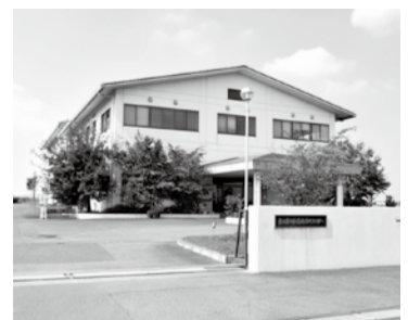
妻沼南河原環境浄化センター
