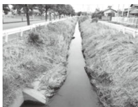
がんがら落排水路
