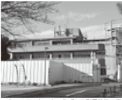
コミュニティセンターみずしろ耐震改修工事
