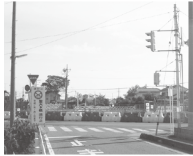
武蔵水路・橋梁架け替え工事
