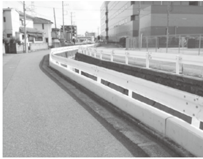
押上町地内・出水対策
