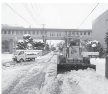
市道における除雪作業
