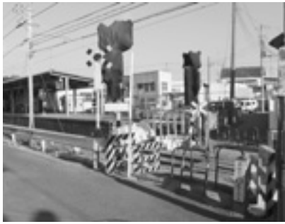
警報機と遮断機の設置
