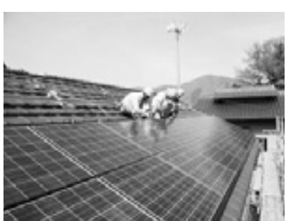
ソーラーパネルの設置
