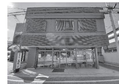
景観に調和させる外観の改修(店舗)
