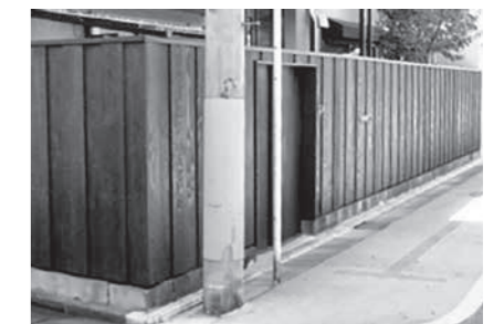
景観に調和させる外観の改修(塀)
