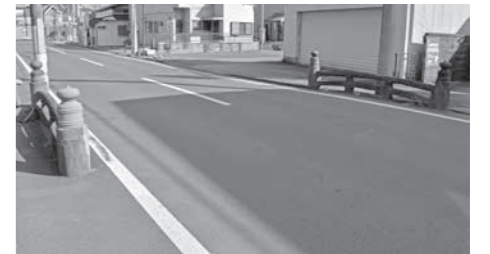
清善寺付近の新兵衛橋跡
