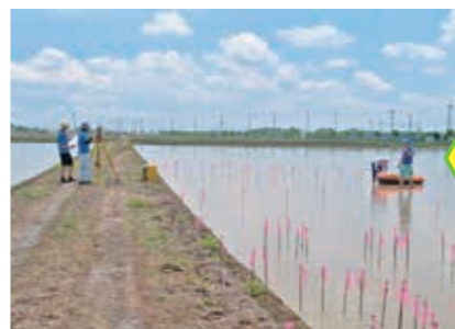
測量機器を使って図形を形成するためのくいとくいを打ちます(くいの総本数6,428本)。
