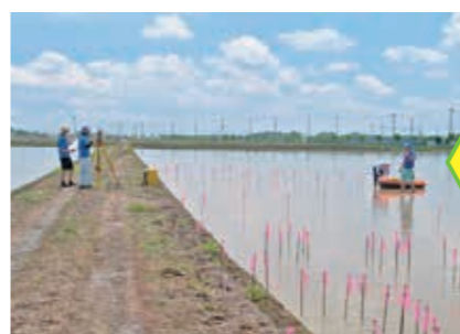
測量機器を使って図形を形成するためのくいを打ちます(くいの総本数6,428本)。
