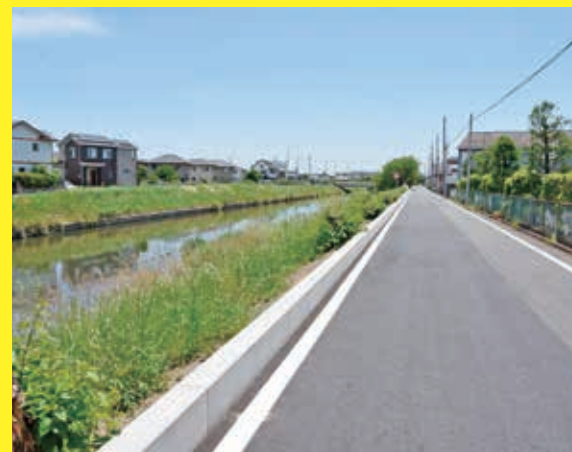
かさ上げ工事を行った忍川沿い
