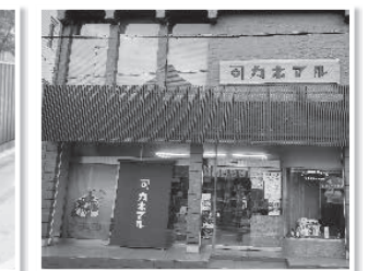
E：店舗の改修(八幡通り)
