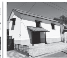
B：外壁の改修
