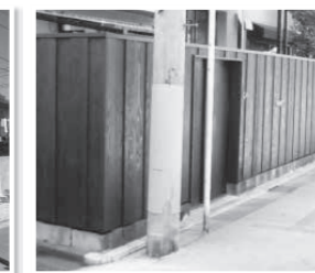
B：塀の改修
