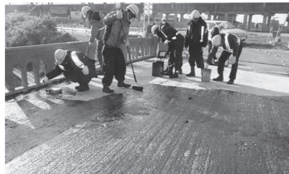
橋りょうの維持補修
