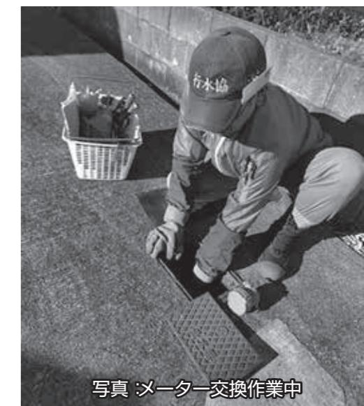
写真:メーター交換作業中
