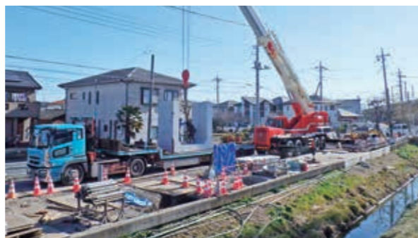
出水対策事業(流域貯留浸透施設)
