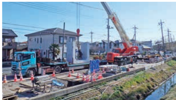
出水対策事業(流域貯留浸透施設)
