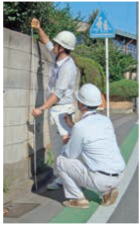
ブロック塀の点検
