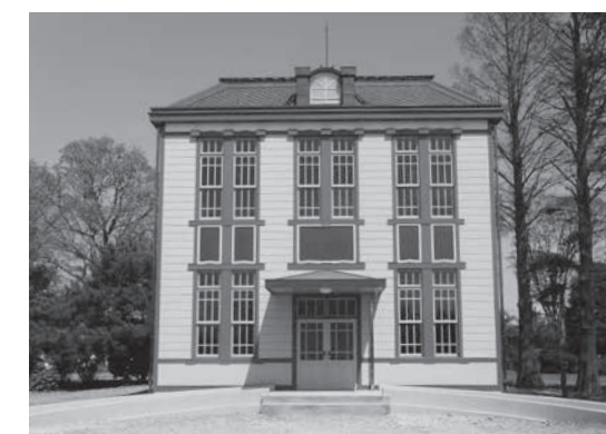
新たな憩いの場として活用が期待される旧忍町信用組合店舗
