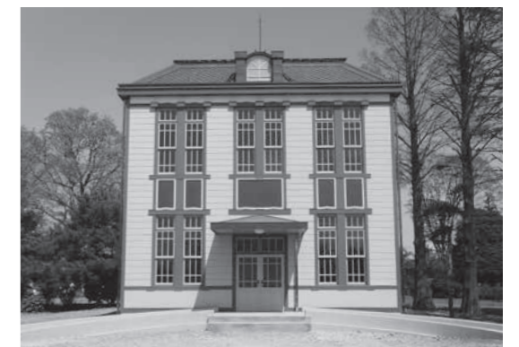
新たな憩いの場として活用が期待される旧忍町信用組合店舗
