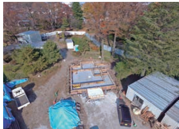
移築先工事現場の様子
