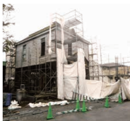
解体中の建物
