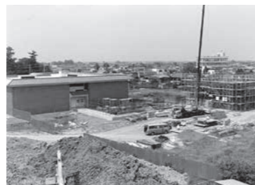
建設中の郷土博物館・御三階櫓
