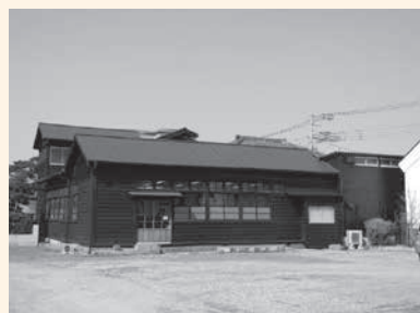
歴史的建築物の改修
