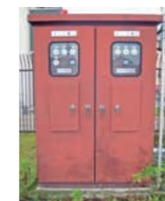
向町排水場において排水ポンプ3号機を増設
