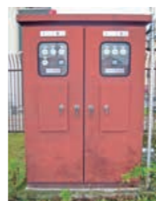
向町排水機場において排水ポンプ3号機を増設
