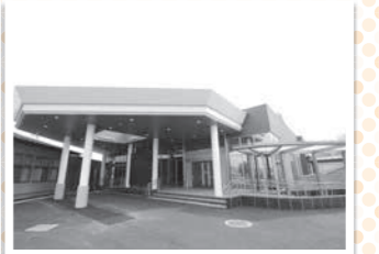
斎場式場棟の改修
