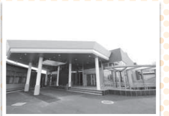
斎場式場棟の改修
