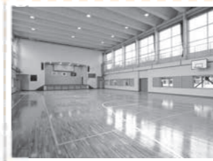
北河原小体育館耐震補強
