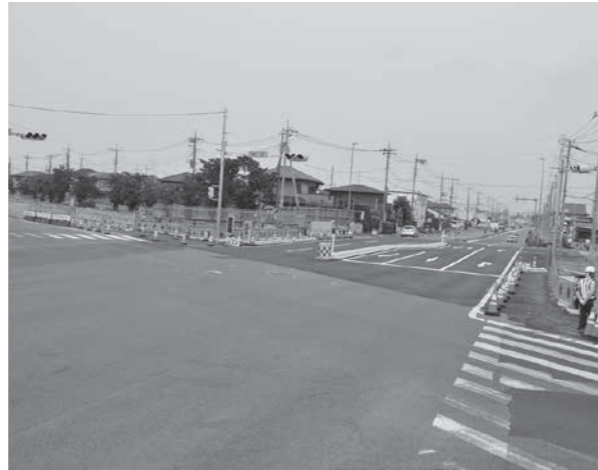
新大橋の様子
