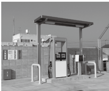
完成した災害対応型危険物自家給油取扱所
