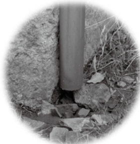
雨どいの排出口
