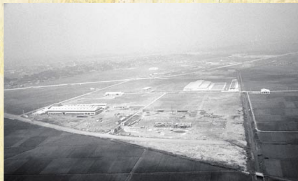
造営中の富士見工業団地（昭和41年）
