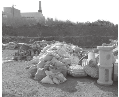
小針焼却場建設予定地に運ばれたがれきや廃材
