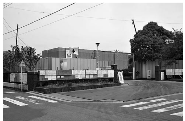
工事の進む旧行田女子高校跡地
