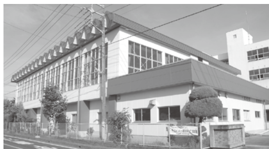
東小学校屋内運動場耐震補強・改修工事
