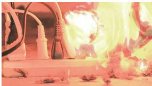
げんしょう トラッキング現象
