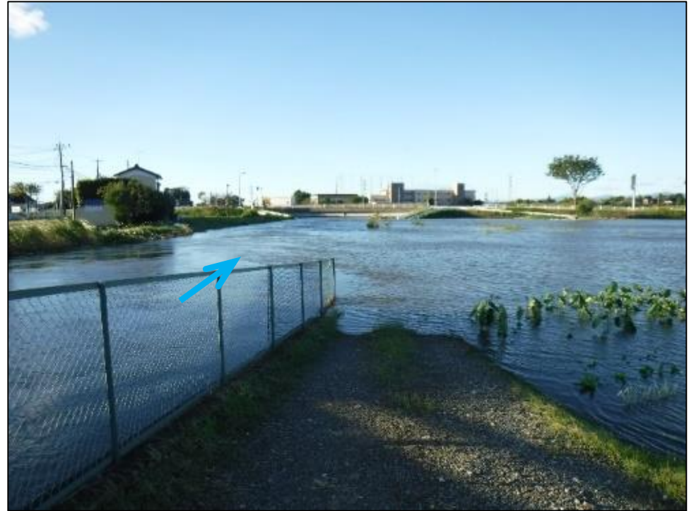
樋の上橋付近
