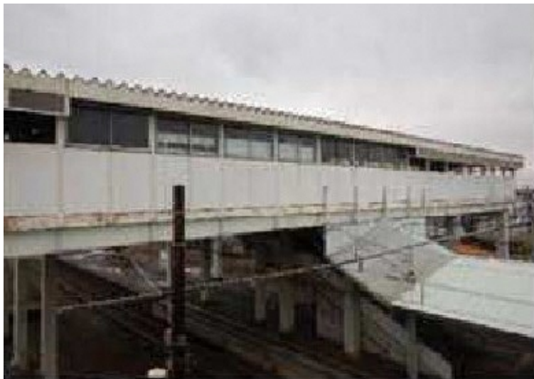
写真 3-1 行田市駅跨線橋
