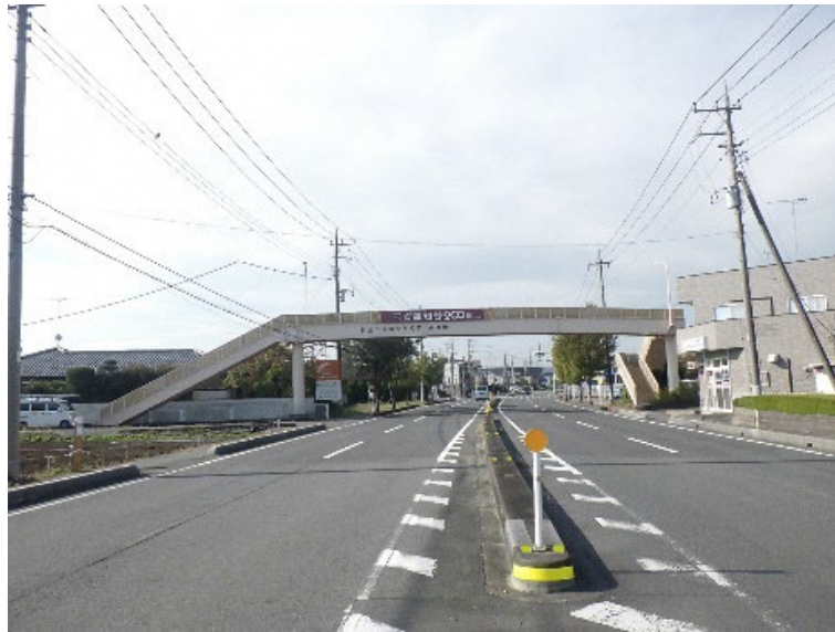
写真 3-3 泉小学校歩道橋
