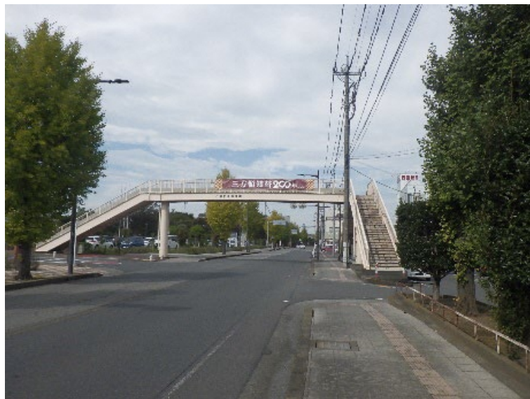
写真 3-4 ときわ通歩道橋
